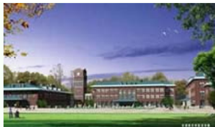
NETGEAR 高性能交換機 —— 應用中國科技大學基礎科學實驗中心
